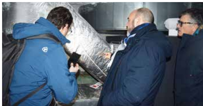
Visite du chantier des travaux au cinéma
