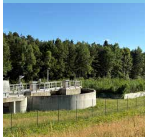
Nouvelle lagune Route du Pont du Bouchet
